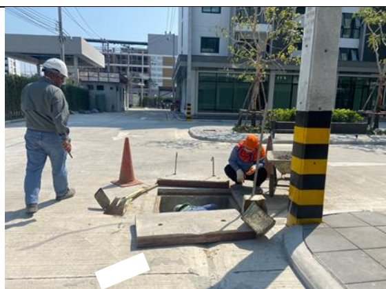
รูปที่ 17 การทำความสะอาดท่อระบายน้ำ
